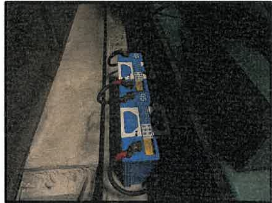
รูปที่ 3-16 ระบบไฟฟ้าสำรอง Battery ขนาด 12 V
