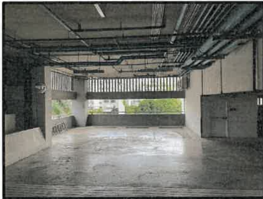
รูปที่ 3-4 ช่องเปิดสำหรับระบายอากาศบริเวณชั้นล่างถึงชั้นที่ 7
